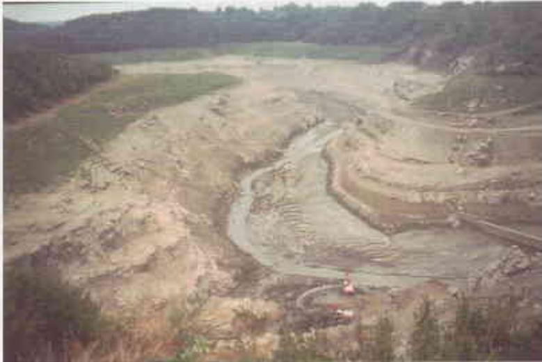
vidange du barrage de Grangent sur la Loire en 1967 a contaminé les eaux de la ville de Blois située à plus de 400 km à l'aval. Dans ce barrage, plus d'1 million de m<sup>3</sup> de matériaux pollués sont à l'heure actuelle accumulés et il n'y a pas de solution réaliste, techniquement et économiquement parlant, à leur élimination.
