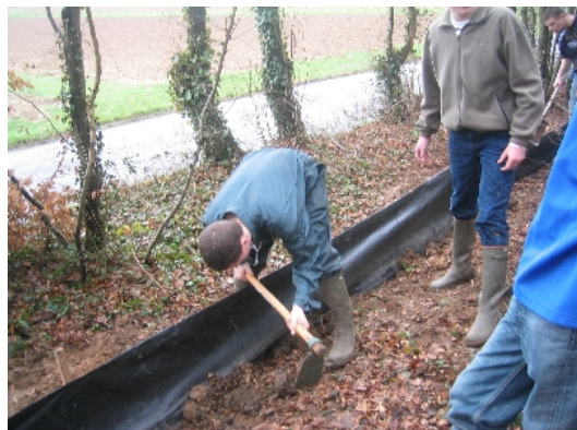
Illustration 1: Installation du barrage temporaire au Bois Magneux
